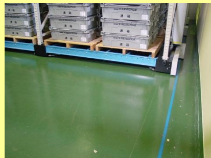
背面側に誘導線を貼付して制御
